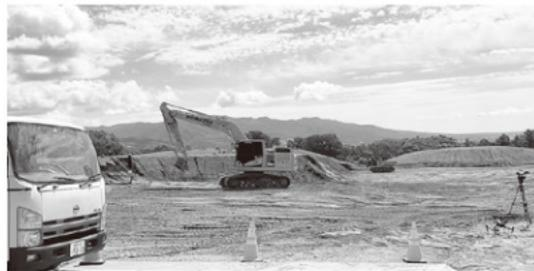
写真右手の丘のように見えるところは、もともとあった表土を剥いで集積したものです。基盤造成が済んだ後、集めた表土を戻し、均していくことになります。
